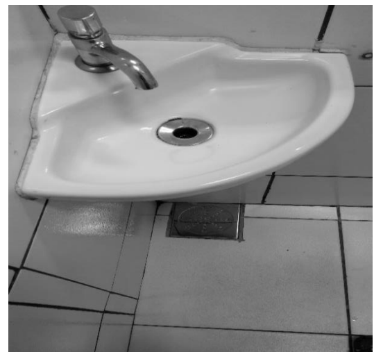
FIGURA 5–Troca do ralo, evitando o mau cheiro Fonte: Próprio autor
