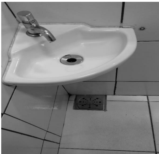
FIGURA 4 – Acesso do mau cheiro pelo ralo Fonte: Próprio autor
